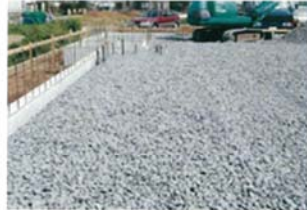
敷き詰められた砂利が振動を分散・吸収します。
